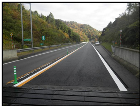
舗装修繕工事
