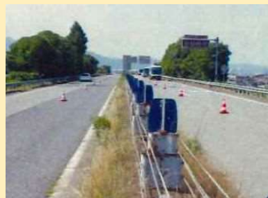
防草シート敷設前
