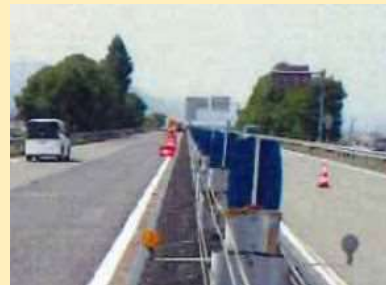
防草シート敷設後
