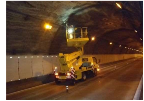
トンネル点検
