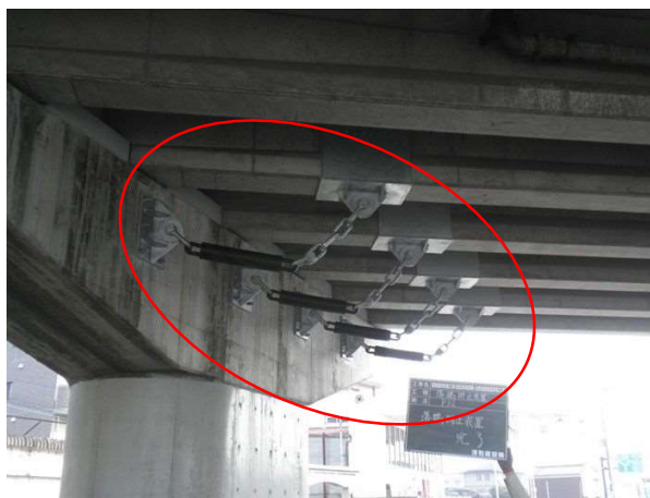
【落橋防止構造の設置】
