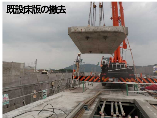
老朽化した床版を切断撤去
