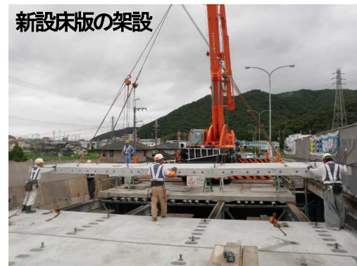
工場で製作した床版を設置することで工事期間を短縮
