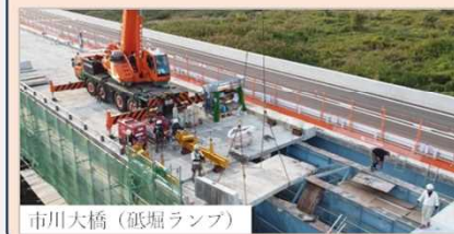
市川大橋(砥堀ランプ)
