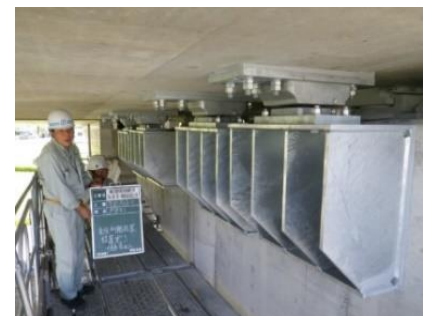
【対策事例：支承部の補強】
