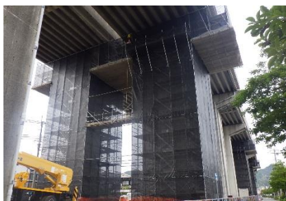
【第8高架橋施工状況（R5.6）】
