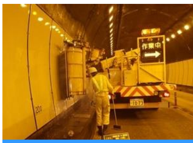
【トンネル清掃状況】
