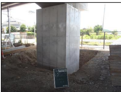
【対策事例：橋脚補強】
