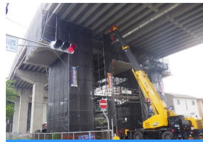
【第8高架橋施工状況（R5.6）】
