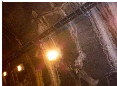
播但第 1 トンネル
