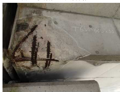
第 2 高架橋(その 3)
